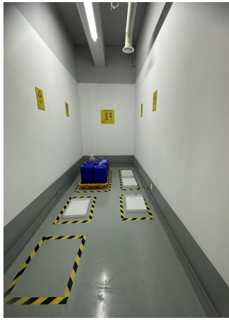
危废库防渗地面
