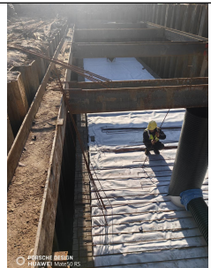
应急事故池施工照片
