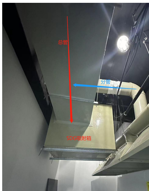
图 6-1 室内废气收集管道图
