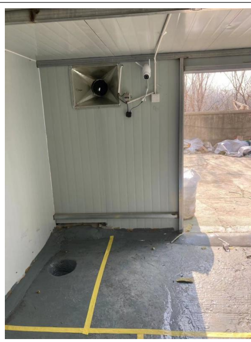
危废仓库内部
