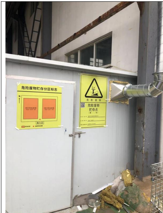
危废仓库及标识牌
