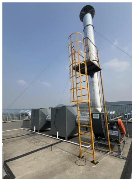
间接水冷+二级活性炭吸附设施+DA002 排气筒
