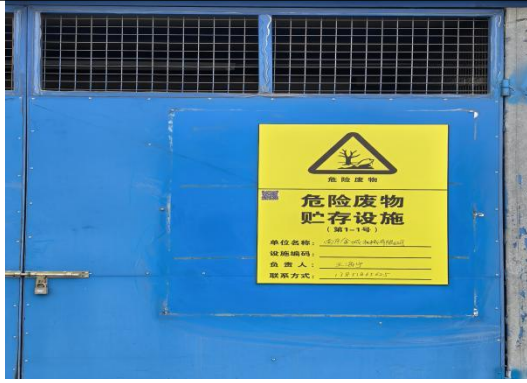
危废库贮存设施标识牌
