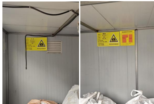
危废仓库内部及环保标志牌
