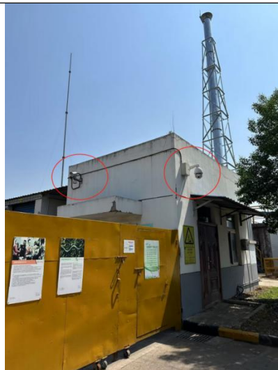
危废库监控设施
