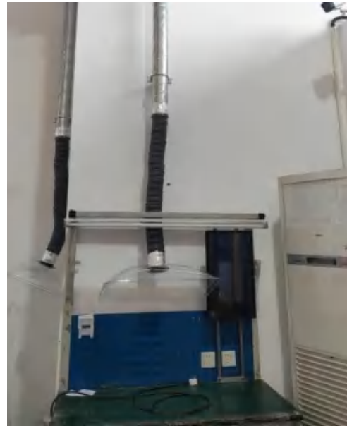
印刷、清洗工位集气罩
