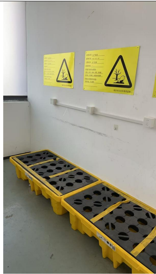
危废仓库内部及环保标志牌
