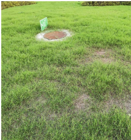
3#厂房污水设施及排口
