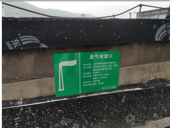
排气筒 (DA005) 标识牌
