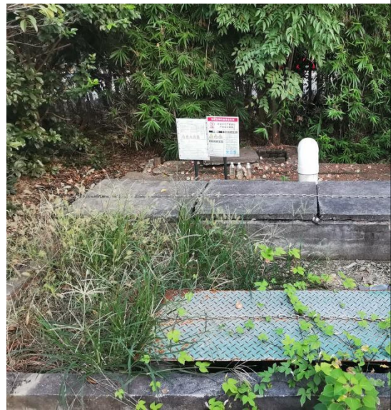
5#厂房污水设施及排口
